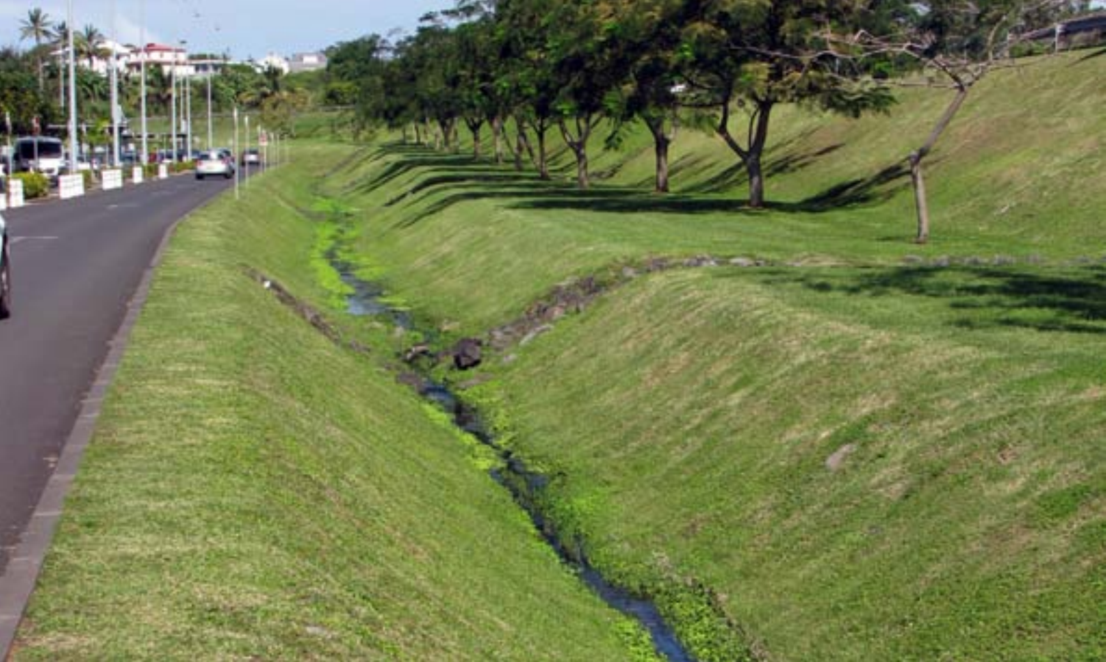
LES FOSSÉS OU NOUES RÉCUPÈRENT LES EAUX DE PLUIES POUR LES GUIDER VERS UN EXUTOIRE ET FAVORISER LEUR INFILTRATION ET ÉVAPORATION. (CENTRE COMMERCIAL GRAND EST, SAINTE-SUZANNE) (FICASA [GBH] – LES ARCHITECTES CVZ)
