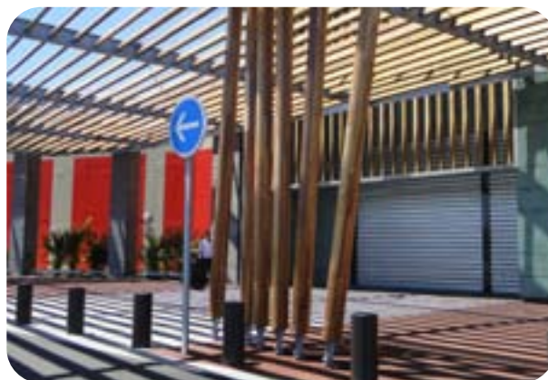
CENTRE COMMERCIAL DUPARC, SAINTE-MARIE (JUMBO SCORE, GROUPE CASINO – ARCHITECTES DE L'ÉPERON)
