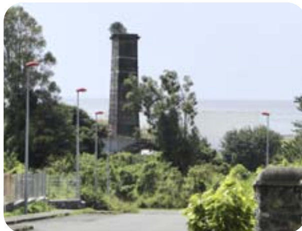
ANCIENNE USINE DE BEAUFONDS, SAINT-BENOÎT
