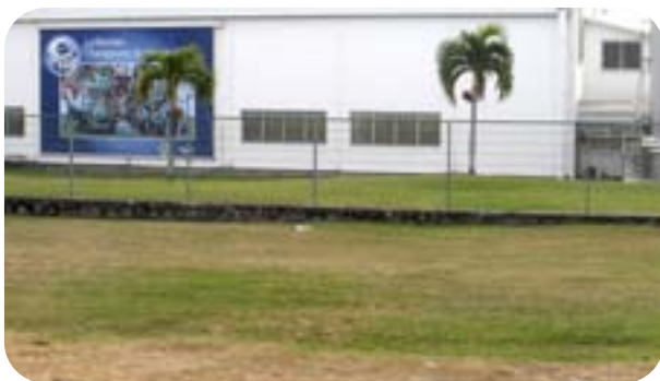
ENTRÉE DES ZONES INDUSTRIELLES DU PORT
