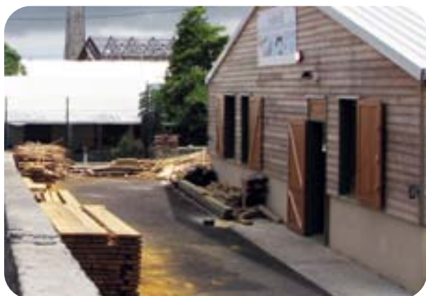
ZONE ARTISANALE VUE BELLE, SAINT-PAUL (THIERRY BONNEVILLE – BERNARD DELANDE [ARCHI.])
