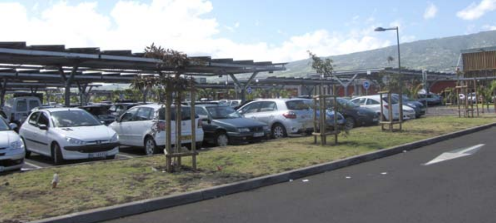
CENTRE COMMERCIAL DE DUPARC (JUMBO SCORE, GROUPE CASINO – ARCHITECTES DE L'ÉPERON)
