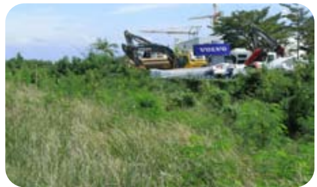
ENTRÉE DES ZONES INDUSTRIELLES DU PORT
