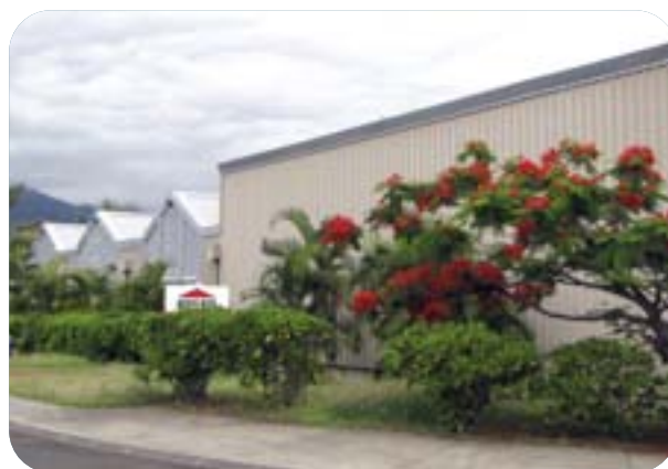
PÉPINIÈRE D'ENTREPRISES DE LA ZONE D'ACTIVITÉS DES SABLES, ÉTANG-SALÉ (SODEGIS – DPV ARCHITECTURE)
