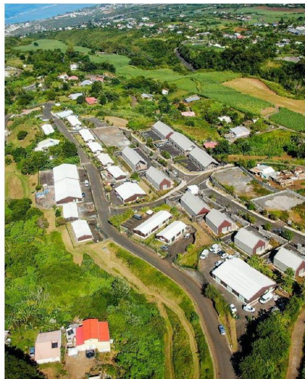
Figure 22 : Zone d'activité de Bras Montvert à Trois-Bassins, photo : LFU
